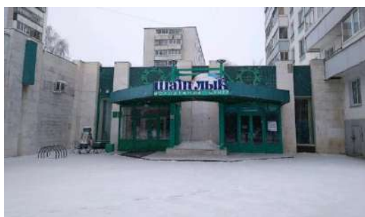
входная зона до капитального ремонта
